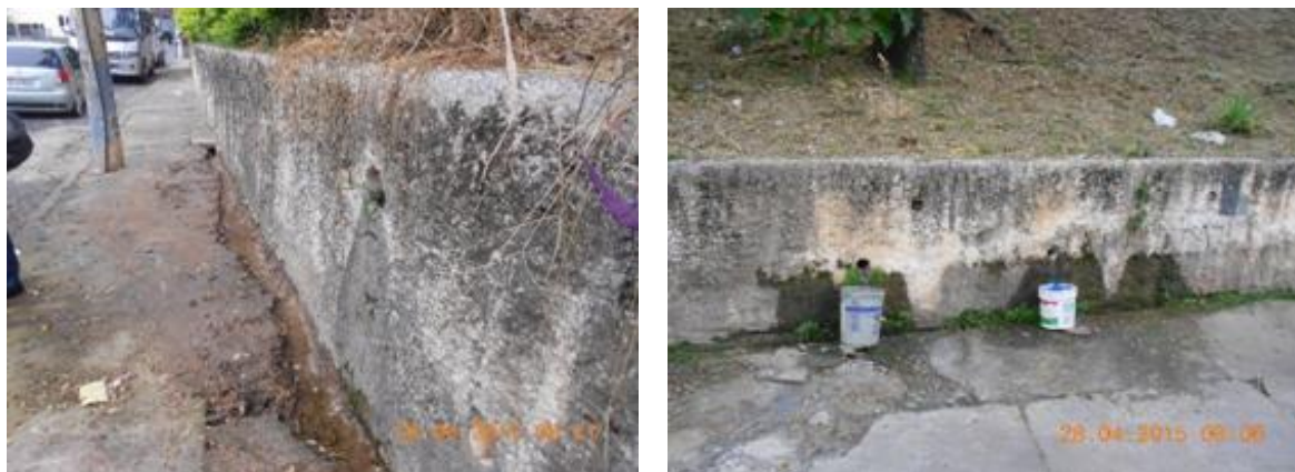
Figuras 36 e 37 - Área da nascente AR 064 antes das intervenções Fonte: Neogeo, 2017
