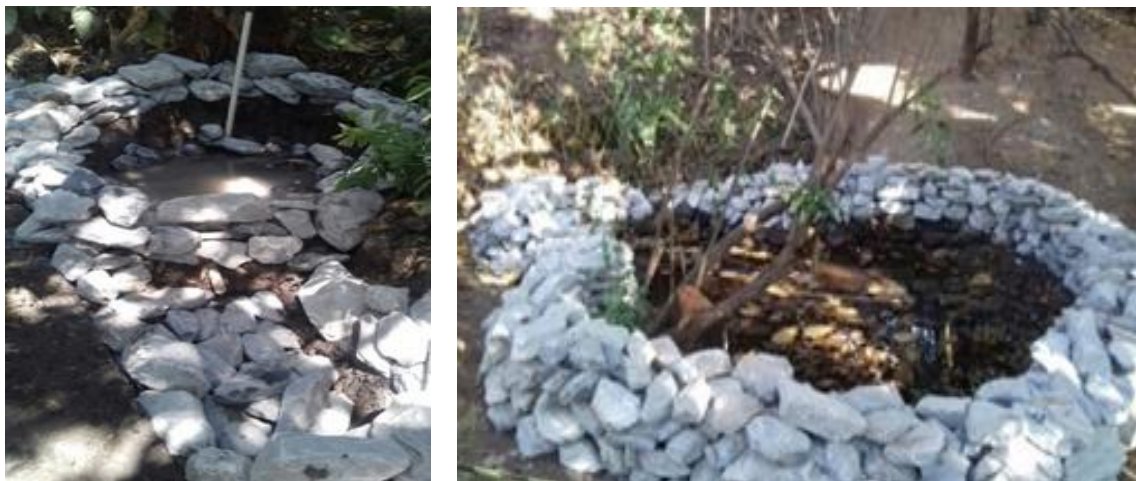
Figuras 5 e 6 - Área da nascente AR 011 revitalizada – Lago do Coração Fonte: Neogeo, 2017
