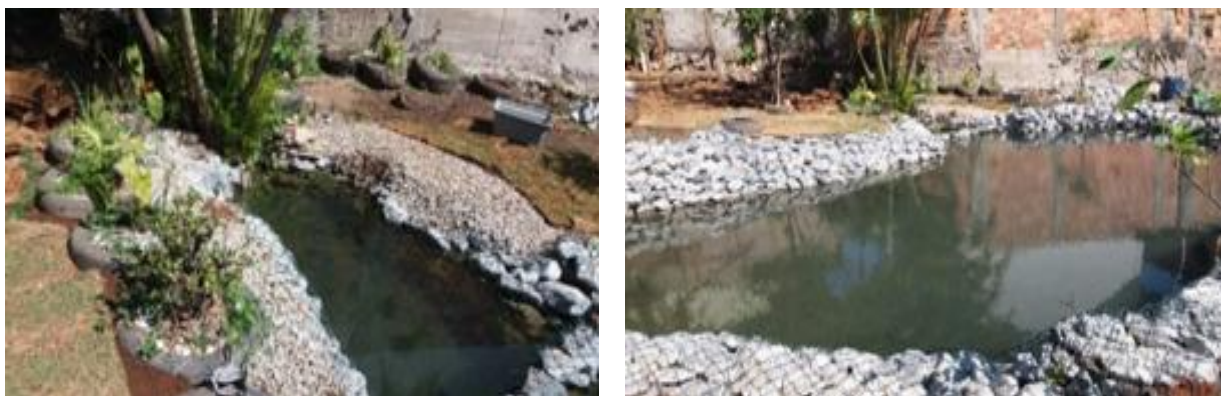
Figuras 11 e 12 - Área da nascente AR 017 revitalizada Fonte: Neogeo, 2017
