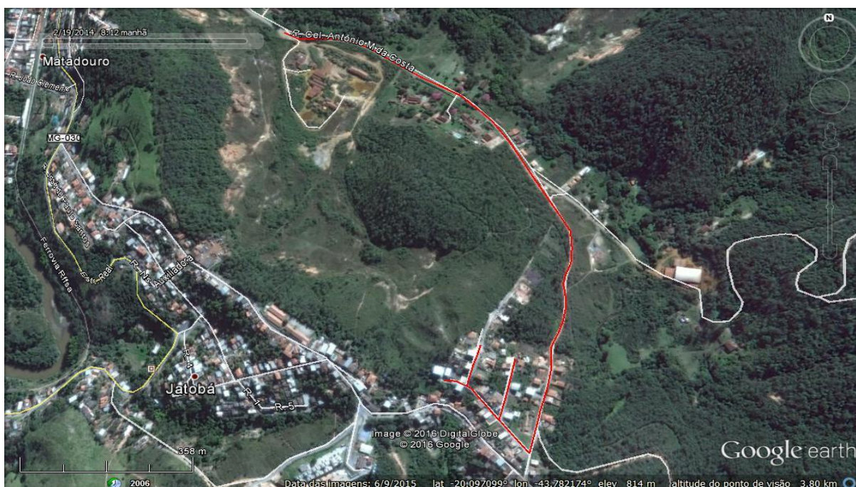
Figura 2.4 - Mapeamento da rede de esgotamento sanitário executada pela Prefeitura no Bairro Morgan.
