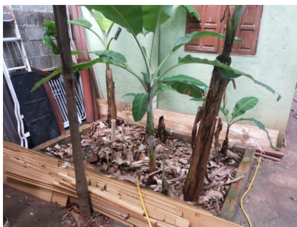
Figura 3.8 -- TEvap em funcionamento com plantio de bananeiras e tubo de inspeção Local: Refúgio São Francisco, Serra do Cipó, Santana do Riacho, MG.
