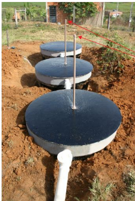
Figura 3.13 – Fossa Séptica Biodigestora instalada.
