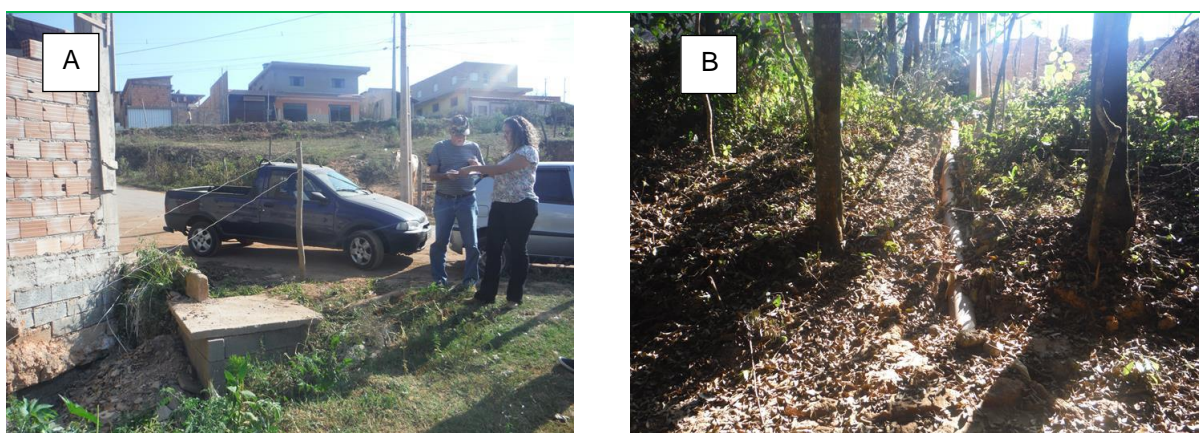
Figura 2.6 – (A) caixa de passagem que recebe esgoto bruto (B) lançamento de esgoto in natura na localidade da Matinha.
