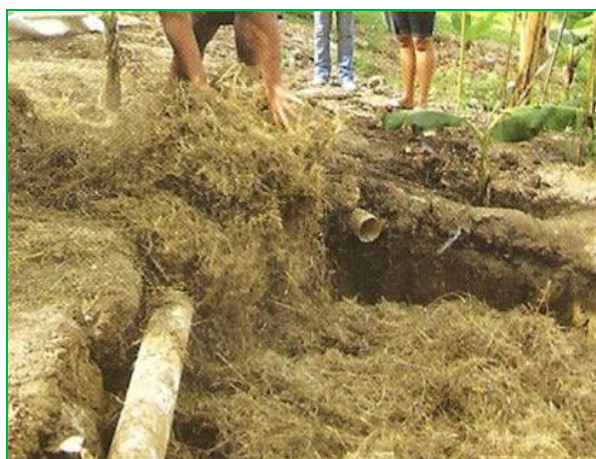
Figura 3.16 – Preenchimento da vala com palha seca.
