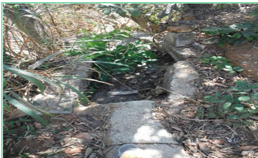
Figura 2.5 – P08: Descarga de drenagem próxima ao lançamento interceptor.
