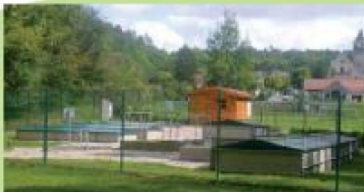
Boissy-la-Rivière (91), extension to 1.000 PE
