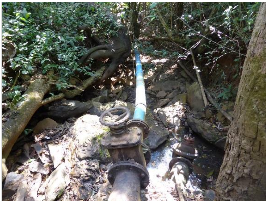
Figura 3.15 – Adutora em PVC 150 mm. Fonte: DHF Consultoria, 2016.
