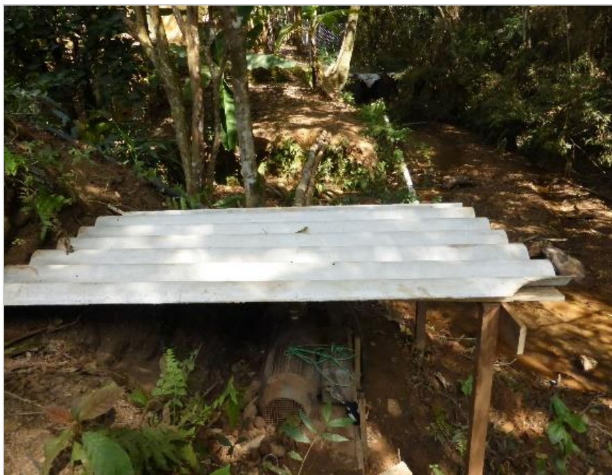
Figura 3.19 – Bomba de adução e injeção de água na rede de distribuição. Fonte: DHF Consultoria, 2016.
