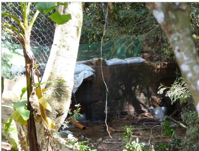
Figura 3.17 – Barramento em concreto alteado.
