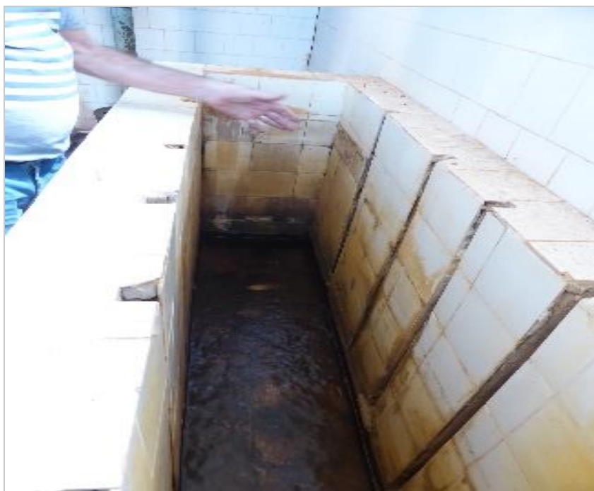
Figura 3.26 – Canal na casa de química.
