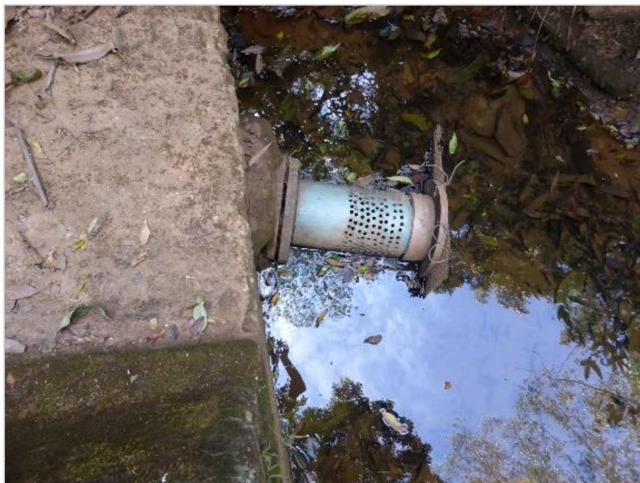
Figura 3.13 – Tomada d'água com crivo precário.
