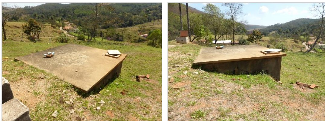
Figura 3.31 – Reservatório de água tratada apoiado.
