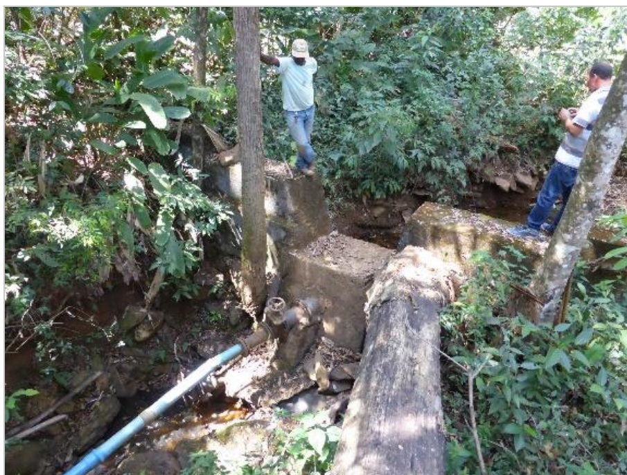
Figura 3.8 – Captação secundária.
