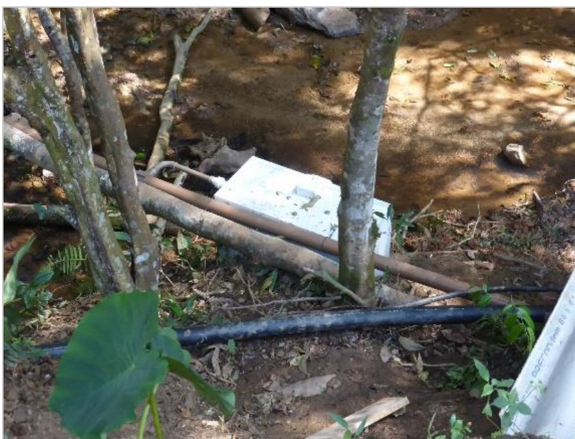
Figura 3.18 – Clorador e tubulação adutora de água tratada (apenas clorada).
