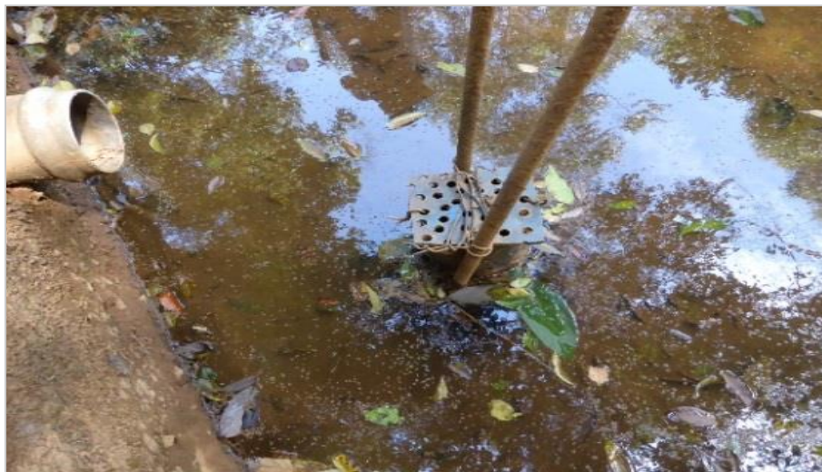
Figura 3.10 – Tomada d'água com crivo precário.
