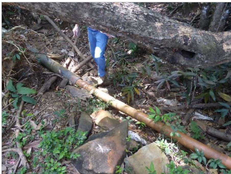
Figura 3.16 – Emendas e diferentes tubos na adutora de água bruta. Fonte: DHF Consultoria, 2016.
