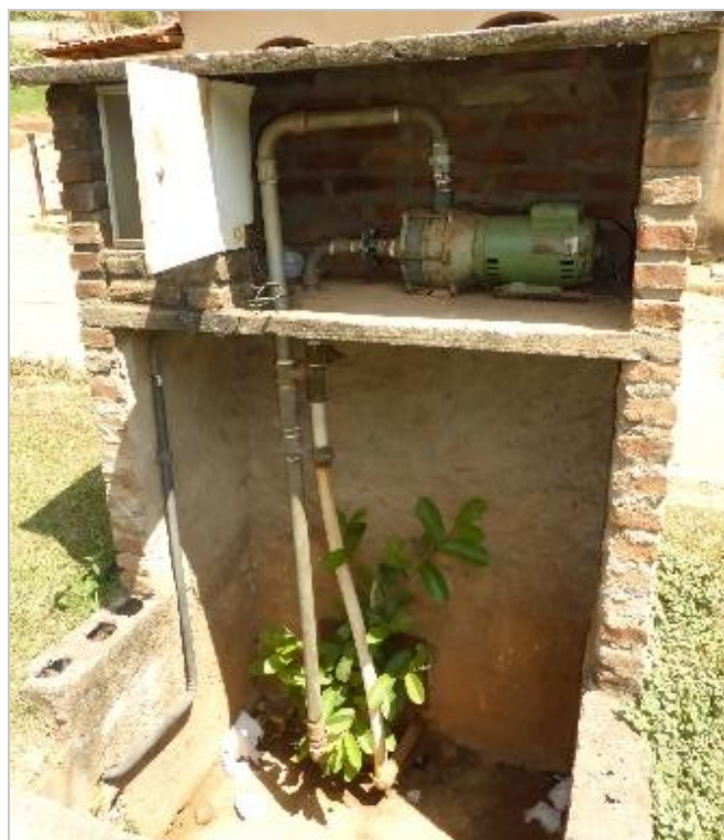
Figura 3.32 – Booster interligado na rede de distribuição.
