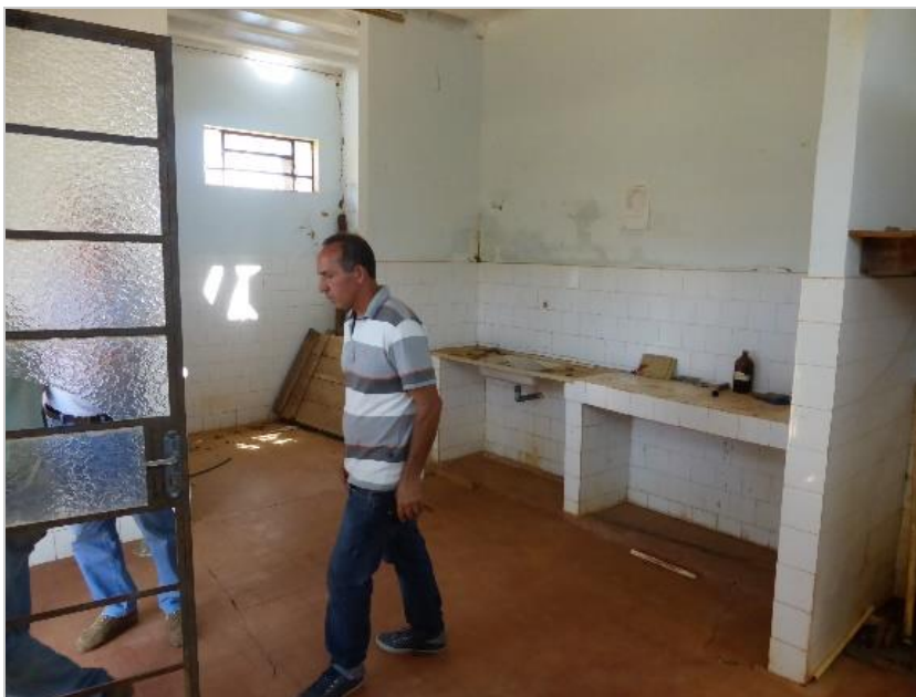
Figura 3.28 – Abandono da estrutura e porta quebrada.
