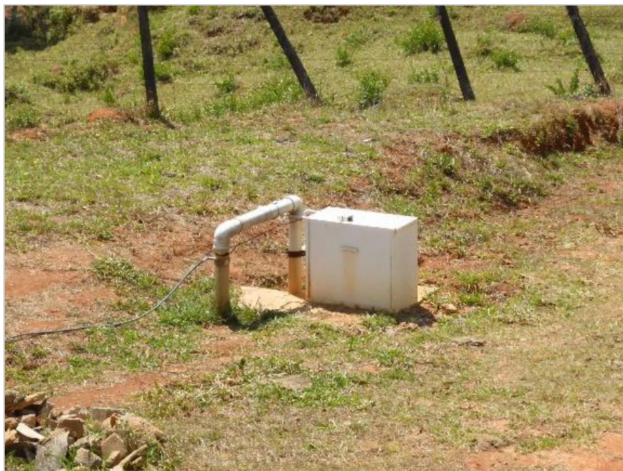
Figura 3.20 – Cloração água.
