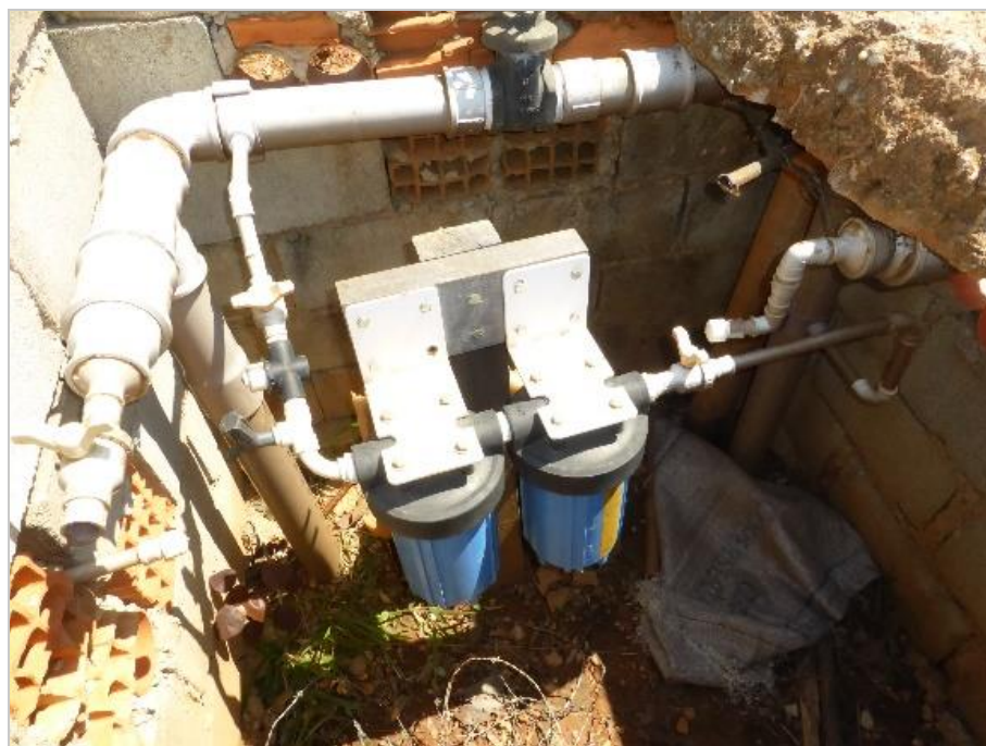
Figura 3.30 – Caixa de chegada da captação secundária – filtros não funcionam. Fonte: DHF Consultoria, 2016.
