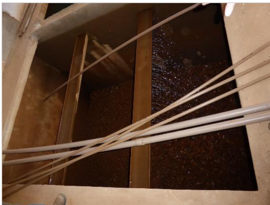
Figura 3.23 – Filtro Lento precário (pré-filtro).
