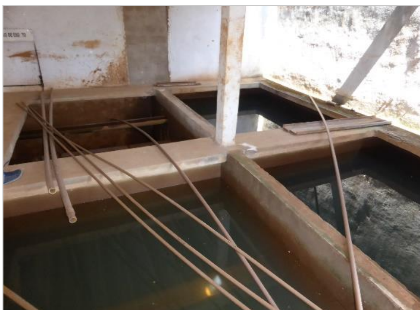
Figura 3.25 – Reservatórios à direita e filtros lentos precários à esquerda (pré-filtro).
