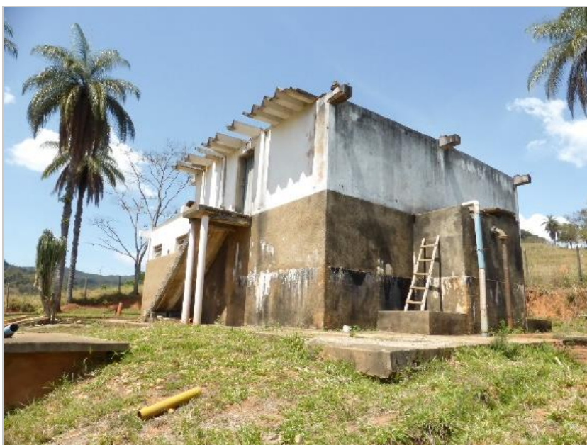
Figura 3.29 – Falta de telhas sobre os filtros.
