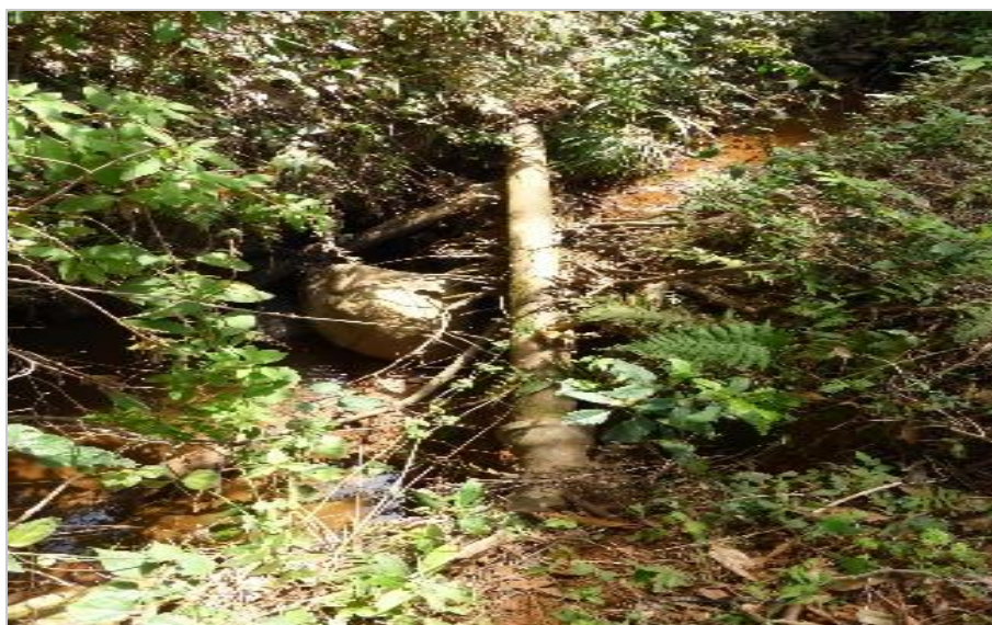
Figura 3.11 – Adutora de água bruta.
