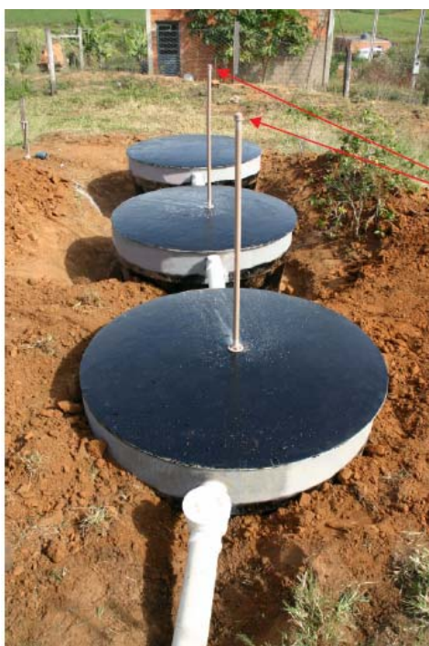
Figura 3.12 – Fossa Séptica Biodigestora instalada.
