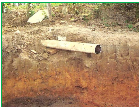
Figura 3.14 – Vala escavada e tubo de lançamento das águas cinzas.
