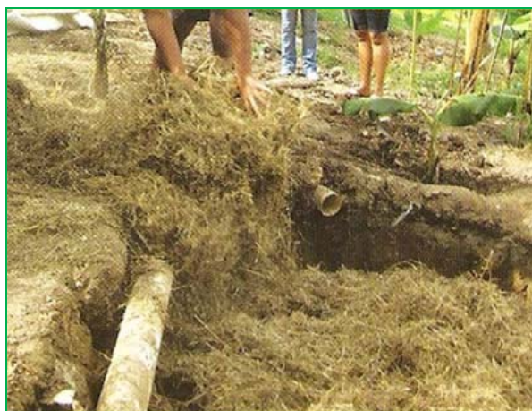
Figura 3.15 – Preenchimento da vala com palha seca.
