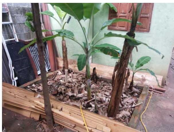
Figura 3.7 – TEvap em funcionamento com plantio de bananeiras e tubo de inspeção Local: Refúgio São Francisco, Serra do Cipó, Santana do Riacho, MG. Fonte: DHF Consultoria, 2017
