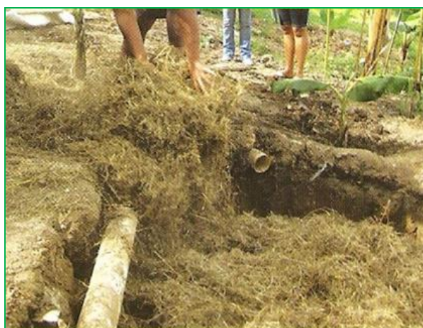
Figura 3.15 – Preenchimento da vala com palha seca.
