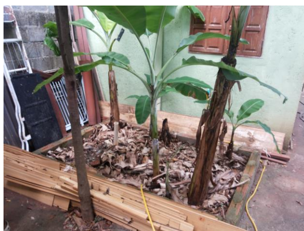
Figura 3.7 — TEvap em funcionamento com plantio de bananeiras e tubo de inspeção Local: Refúgio São Francisco, Serra do Cipó, Santana do Riacho, MG. Fonte: DHF Consultoria, 2017
