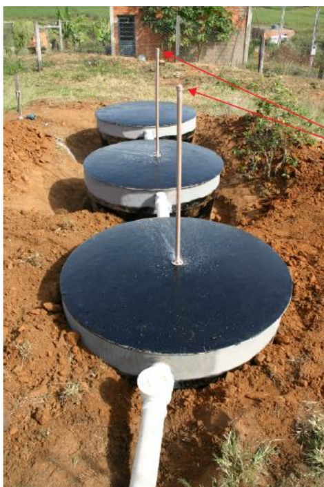
Figura 3.12 – Fossa Séptica Biodigestora instalada.
