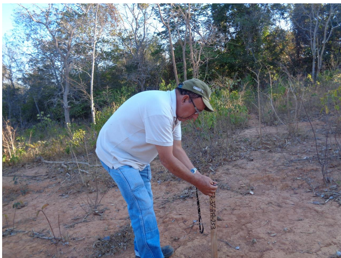
Figura 4: Locação das Bacias de Contenção. Fonte: Localmaq, 2017
