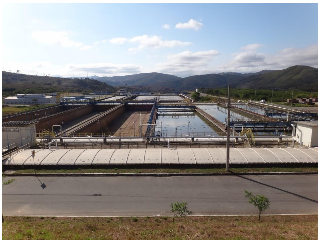
Figura 107. Vista Parcial da ETE Arrudas
