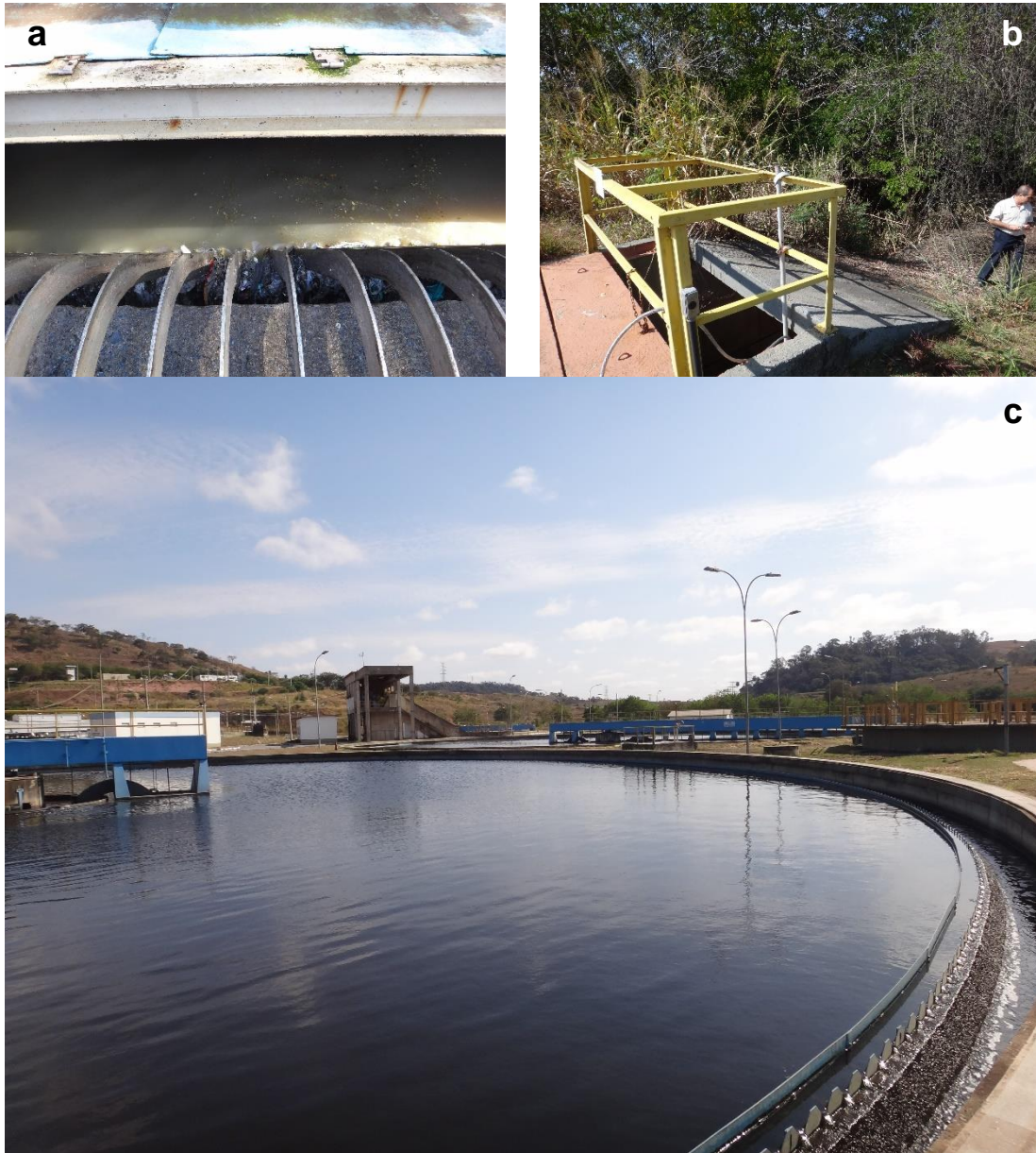
Figura 113. Coleta de amostras de esgotos: (a) tomada d'água (afluente), (b) saída do esgoto tratado (efluente) e (c) decantador final da ETE Arrudas.
