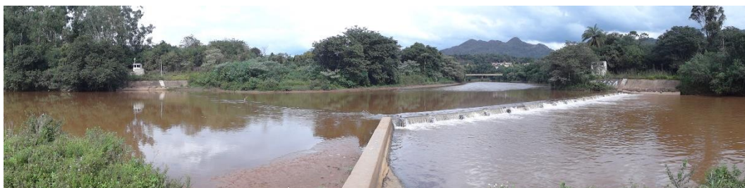
Figura 63. Rio das Velhas em Bela Fama (RV-02), município de Nova de Lima, na estação seca, em junho de 2016 – vista para montante
