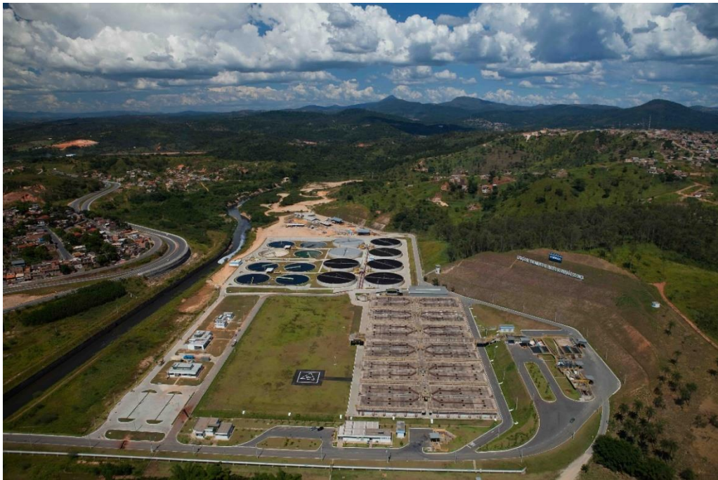
Figura 108. Vista aérea da ETE Onça
