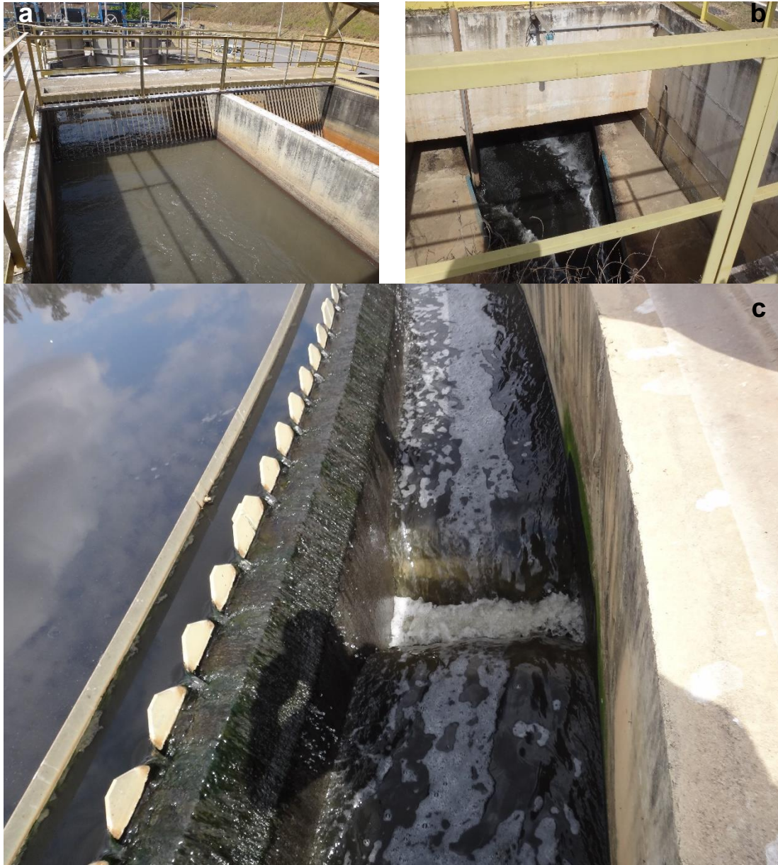
Figura 114. Coleta de amostras de esgotos: (a) tomada d'água (afluente), (b) saída do esgoto tratado (efluente) e (c) decantador final da ETE Onça.
