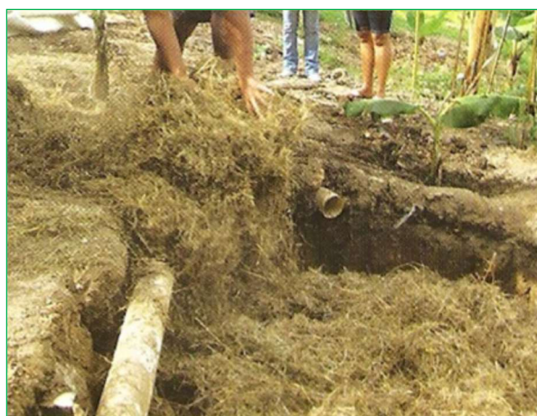
Figura 4.12 – Preenchimento da vala com palha seca.
