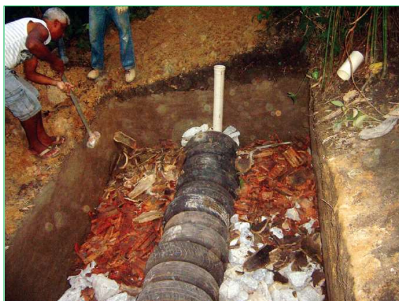
Figura 4.3 – TEvap – Tubo de entrada na câmara e enchimento da trincheira com entulho.
