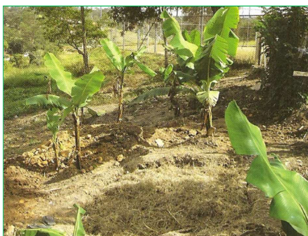
Figura 4.13 – Vala preenchida abaulada e com plantio no entorno
