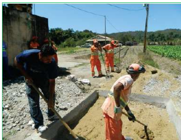
Figura 4.4 – Enchimento da trincheira com camada de areia.
