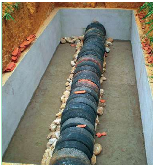
Figura 4.2 – TEvap – Trincheira impermeabilizada e câmara de digestão montada.
