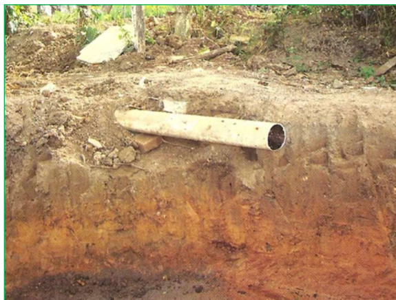
Figura 4.11 – Vala escavada e tubo de lançamento das águas cinzas.
