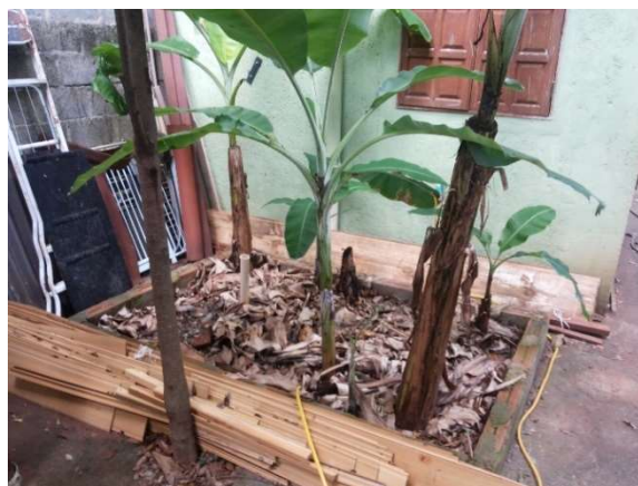
Figura 4.11 – TEvap em funcionamento com plantio de bananeiras e tubo de inspeção Local: Refúgio São Francisco, Serra do Cipó, Santana do Riacho, MG.
