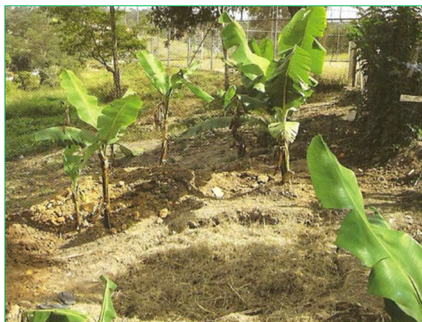
Figura 4.17 – Vala preenchida abaulada e com plantio no entorno
