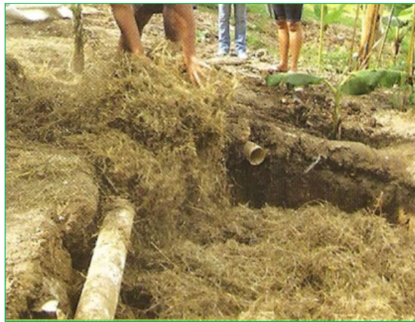
Figura 4.16 – Preenchimento da vala com palha seca.
