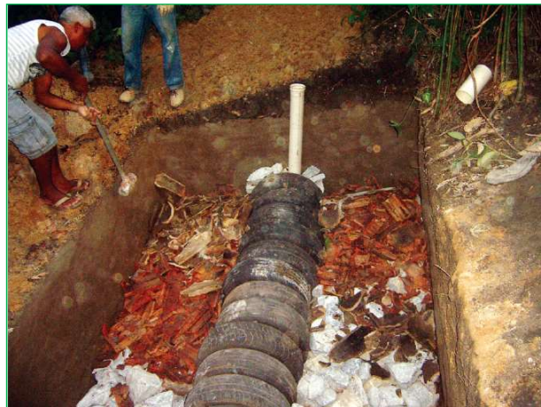
Figura 4.7 – TEvap – Tubo de entrada na câmara e enchimento da trincheira com entulho. Fonte: Leal, 2014.
