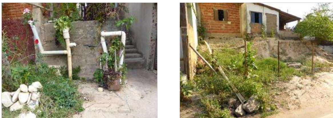
Figura 4.3 – Lançamento em fossa rudimentar coletiva, em fossa rudimentar individual, em local destinado a passeio e sob a via, respectivamente – Parte Alta, Penedia.
