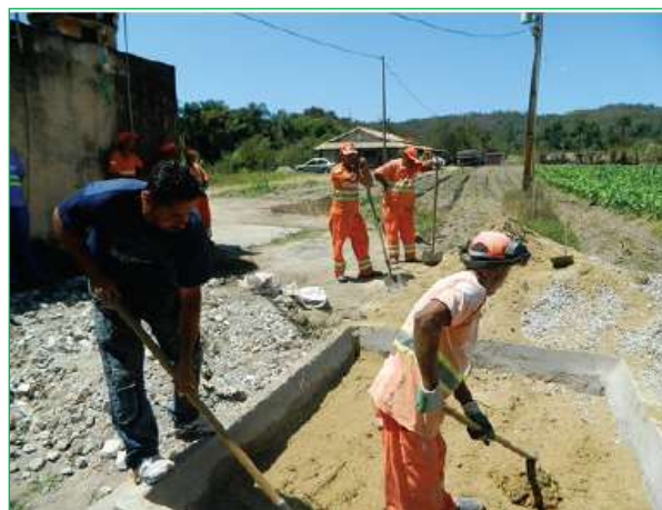
Figura 4.8 – Enchimento da trincheira com camada de areia. Fonte: Leal, 2014.
