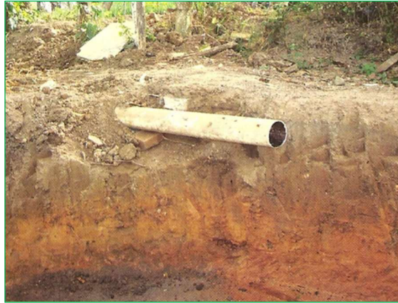
Figura 4.15 – Vala escavada e tubo de lançamento das águas cinzas.
