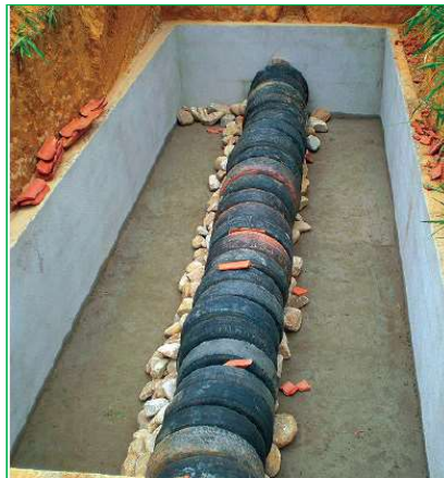
Figura 4.6 – TEvap – Trincheira impermeabilizada e câmara de digestão montada. Fonte: Leal, 2014.
