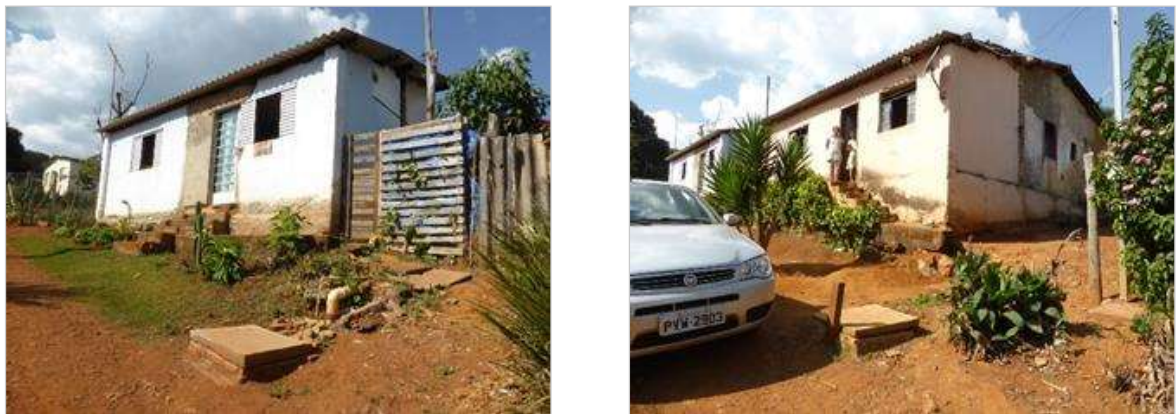
Figura 4.2 – Residências com caixa onde é feita a ligação à rede coletora.
