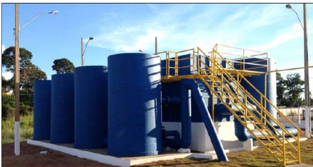
Figura 4.2 – Modelo da ETA Pré- Fabricada Convencional (ETA Pré-Fabricada operada pela Caerd – Porto Velho / RO)
