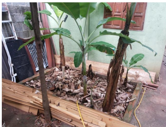
Figura 4.7 – TEvap em funcionamento com plantio de bananeiras e tubo de inspeção Local: Refúgio São Francisco, Serra do Cipó, Santana do Riacho, MG. Fonte: DHF Consultoria, 2017
