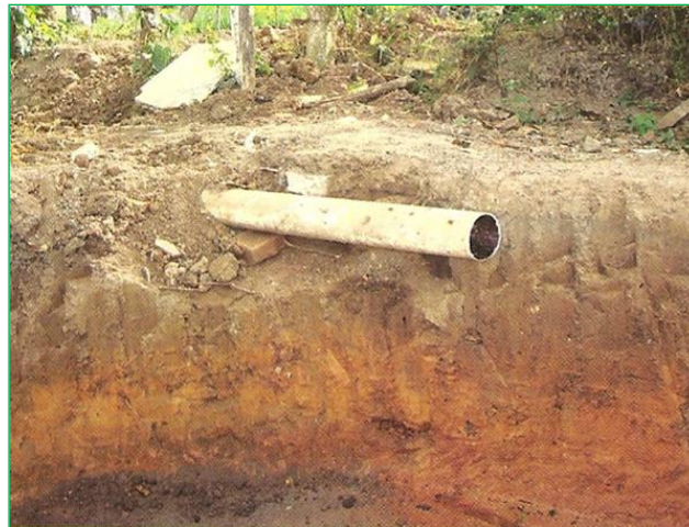
Figura 4.14 – Vala escavada e tubo de lançamento das águas cinzas. Fonte: Leal, 2016.
