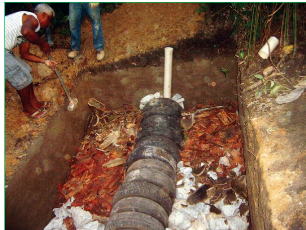
Figura 4.3 – TEvap – Tubo de entrada na câmara e enchimento da trincheira com entulho. Fonte: Leal, 2014.
