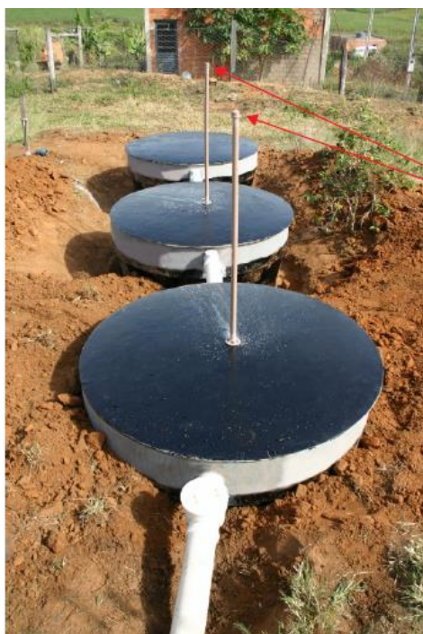
Figura 4.12 – Fossa Séptica Biodigestora instalada.
