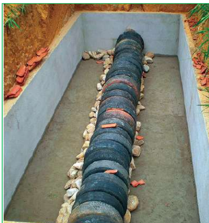
Figura 4.2 – TEvap – Trincheira impermeabilizada e câmara de digestão montada. Fonte: Leal, 2014.
