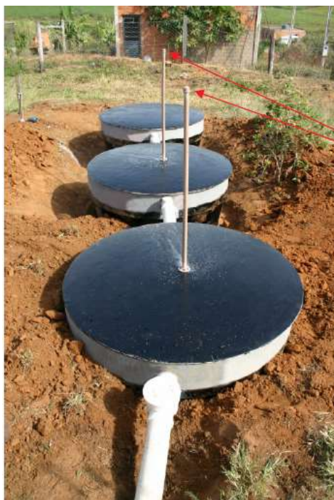
Figura 4.12 – Fossa Séptica Biodigestora instalada.
