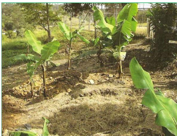
Figura 4.16 – Vala preenchida abaulada e com plantio no entorno
