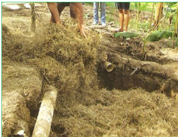
Figura 4.15 – Preenchimento da vala com palha seca.
