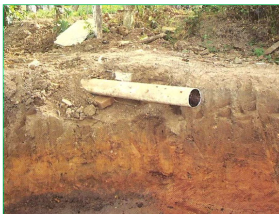
Figura 4.14 – Vala escavada e tubo de lançamento das águas cinzas.
