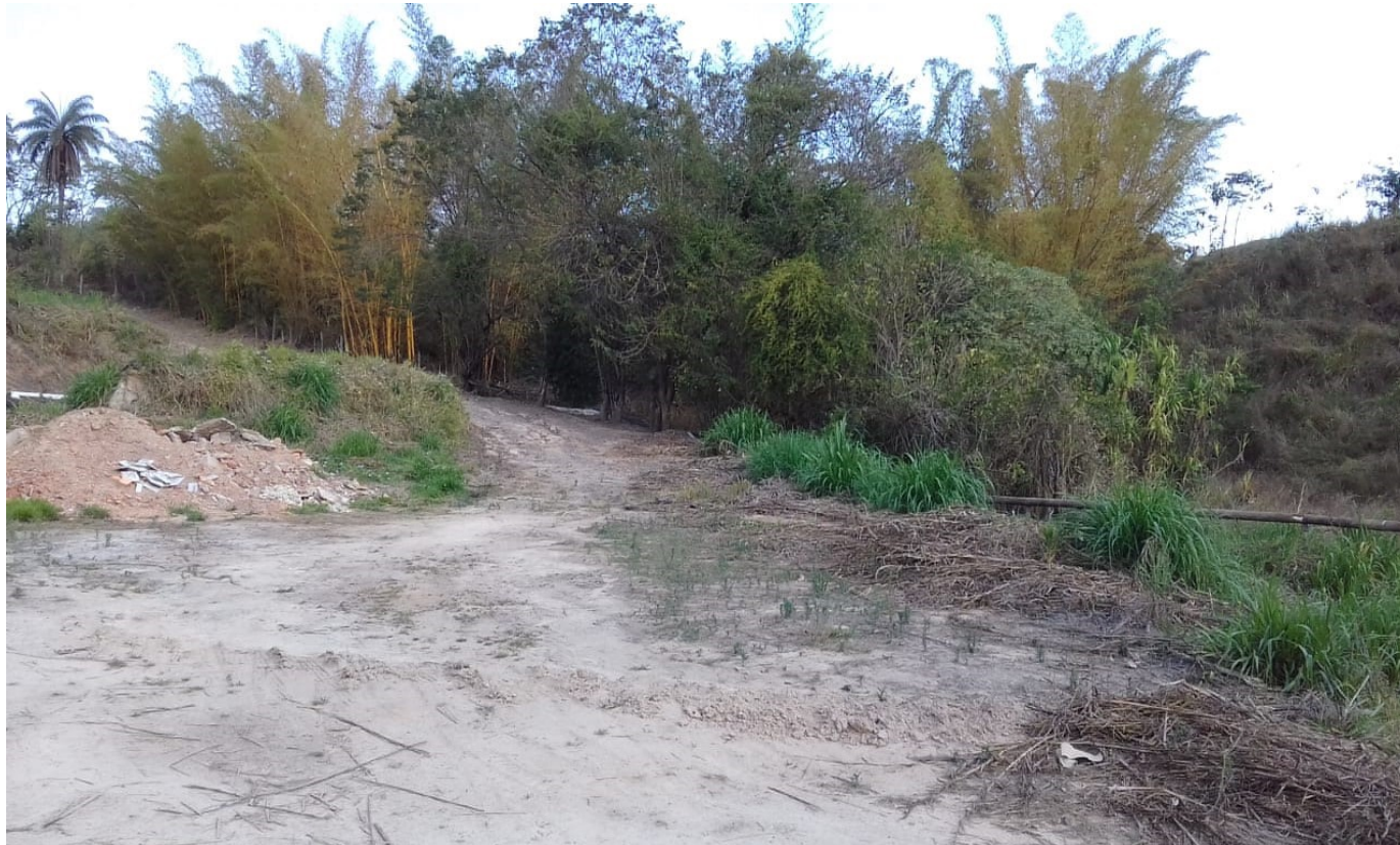
Foto 02 – Área de instalação do galpão
