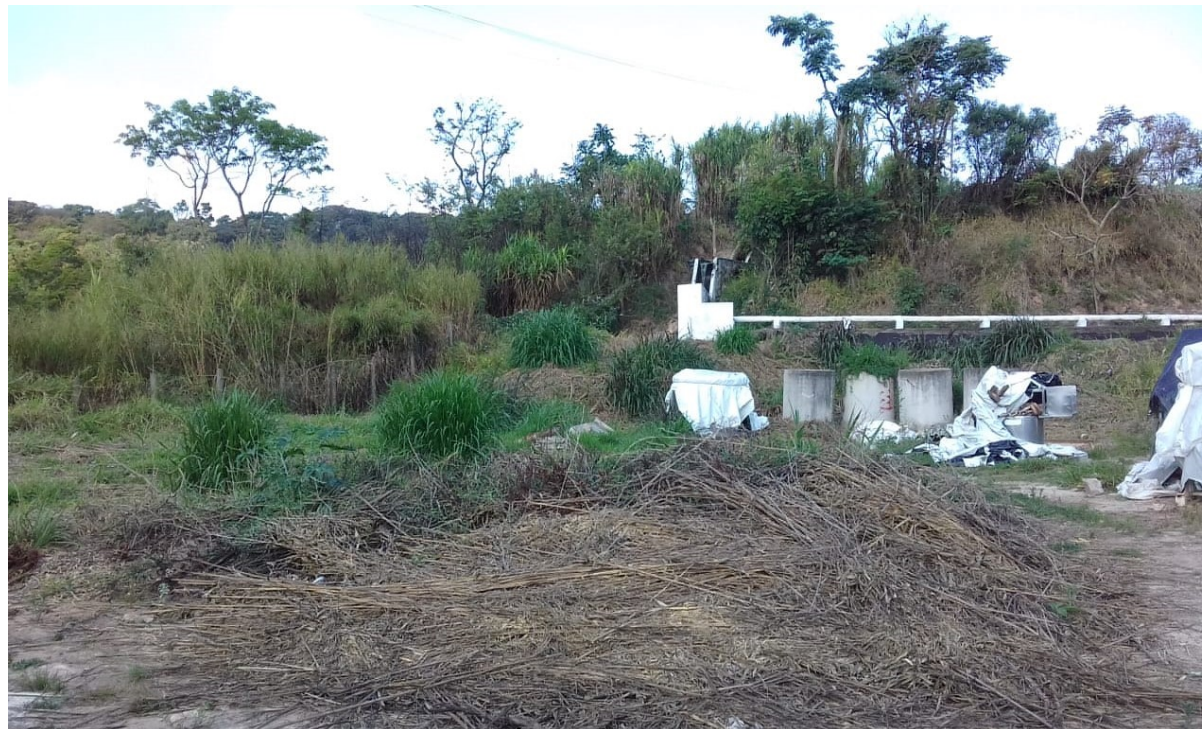
Foto 01 – Área de instalação do galpão
