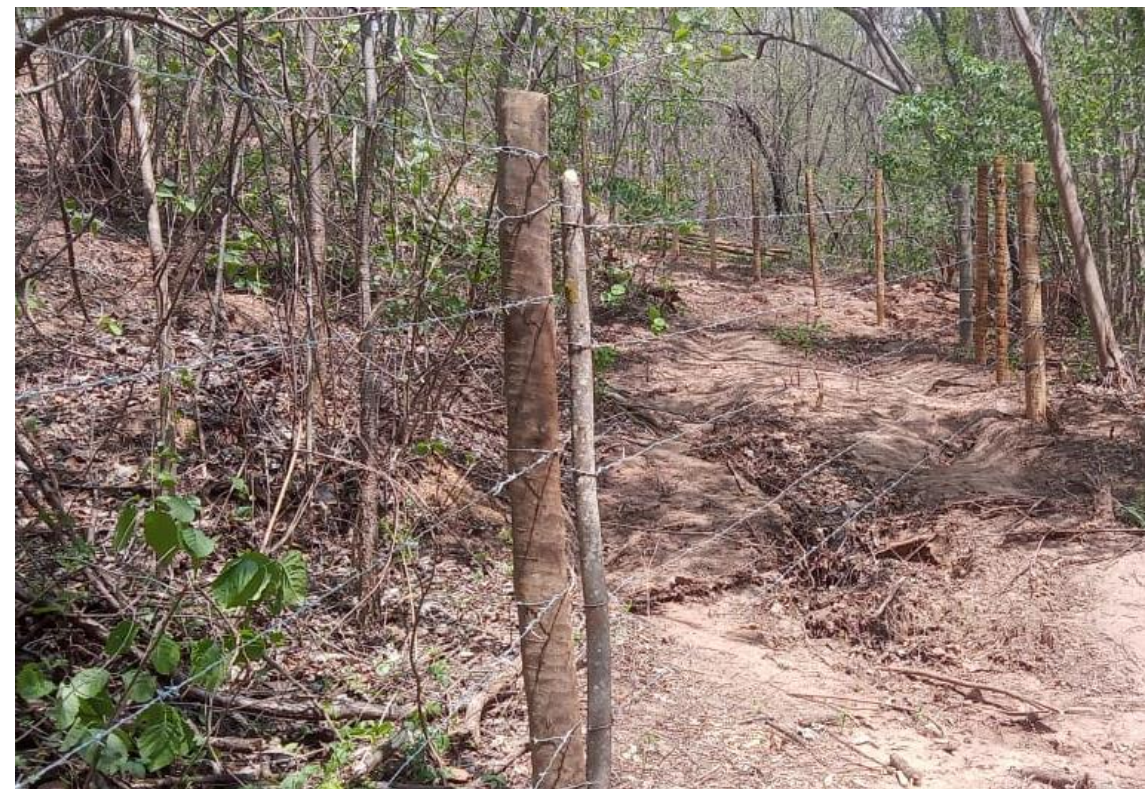
Execução de cercamento Fonte: FORTAL ENGENHARIA (2022)
