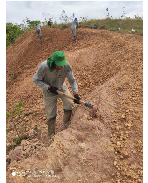
Reconformação de talude
