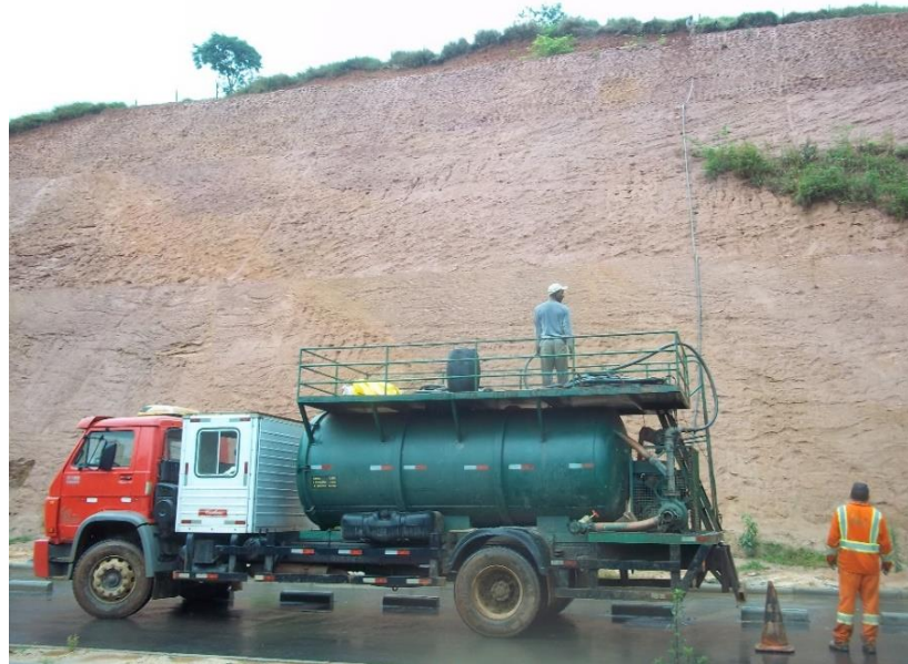
Execução de hidro-semeadura
