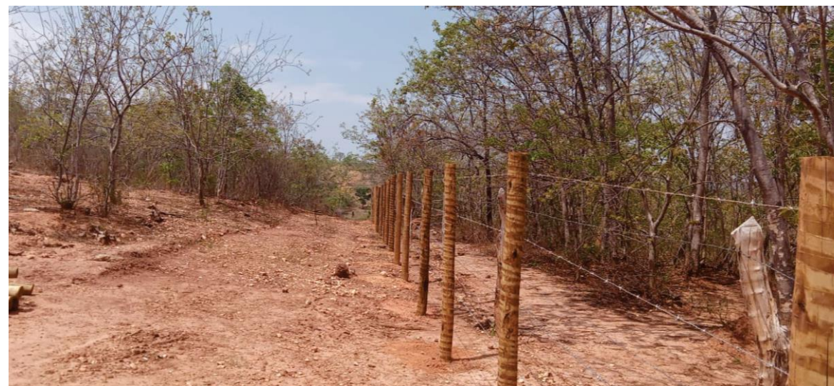
Cercamento executado na propriedade do Sr. José Silvério Fonte: FORTAL ENGENHARIA (2022)
