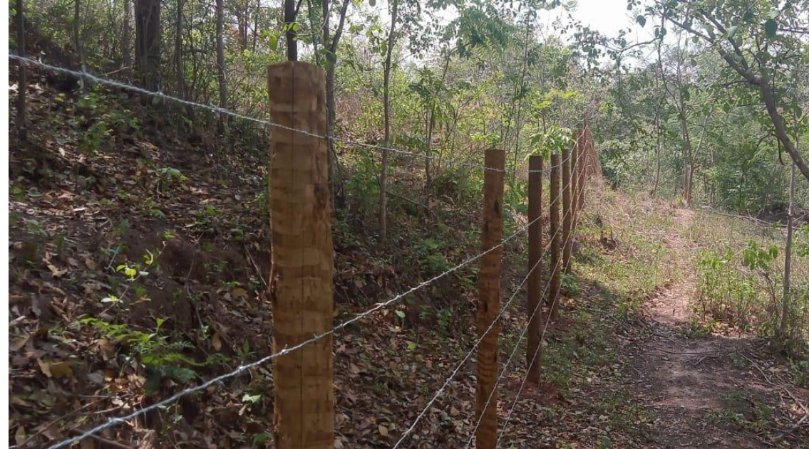
Cercamento executado na propriedade do Sr. José Silvério Fonte: FORTAL ENGENHARIA (2022)
