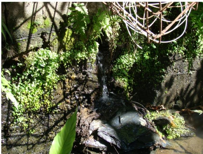
Figura 77: Ponto de exfiltração junto ao muro
