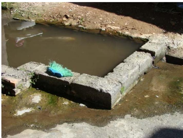
Figura 80: Reservatório com evidência de sedimentos
