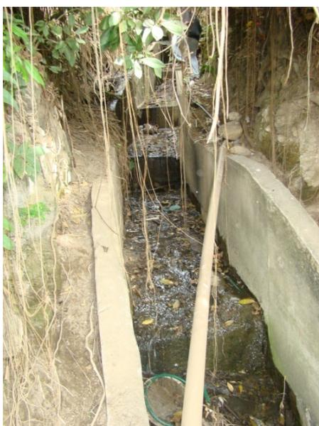
Figura 151: Água da nascente drenada para a rede de esgoto
