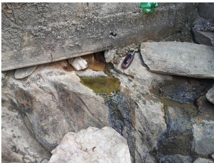
Figura 34: Muro sobre afloramento rochoso
