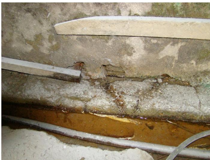
Figura 131: Ponto de exfiltração dentro da estufa de lanternagem
