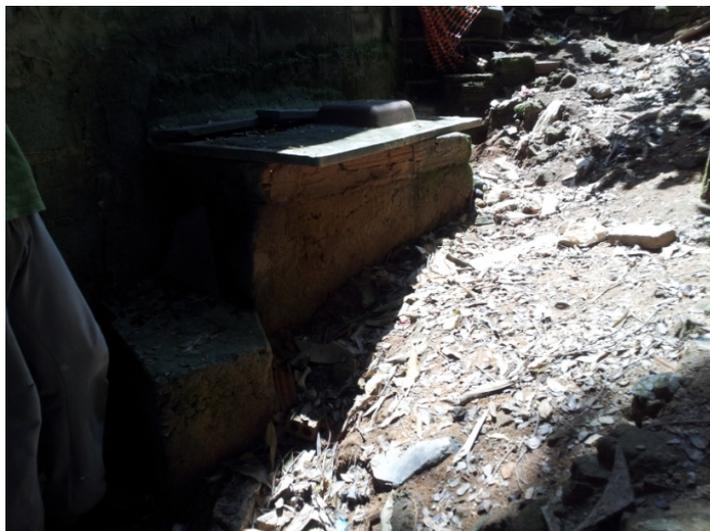
Figura 170: Caixa onde ocorre a exfiltração da água
