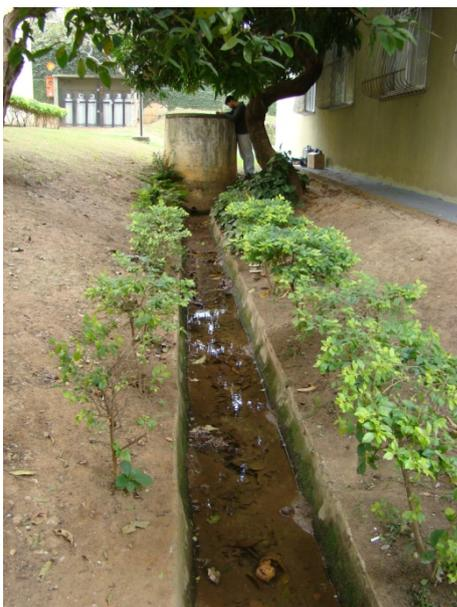
Figura 143: Canaleta construída para drenar a água da nascente
