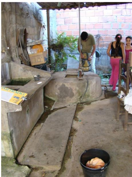
Figura 104: Nascente com exfiltração dentro da cisterna
