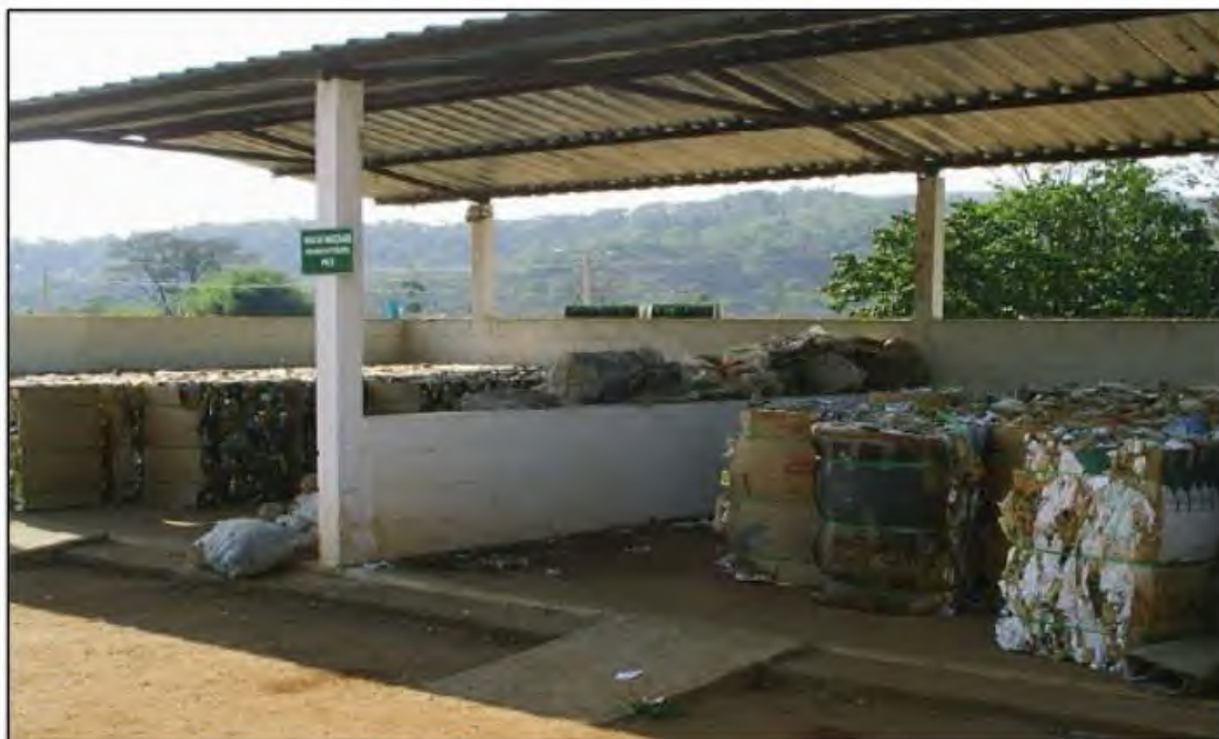
Figura 3.20 - Unidade de triagem e compostagem – Processamento de recicláveis
